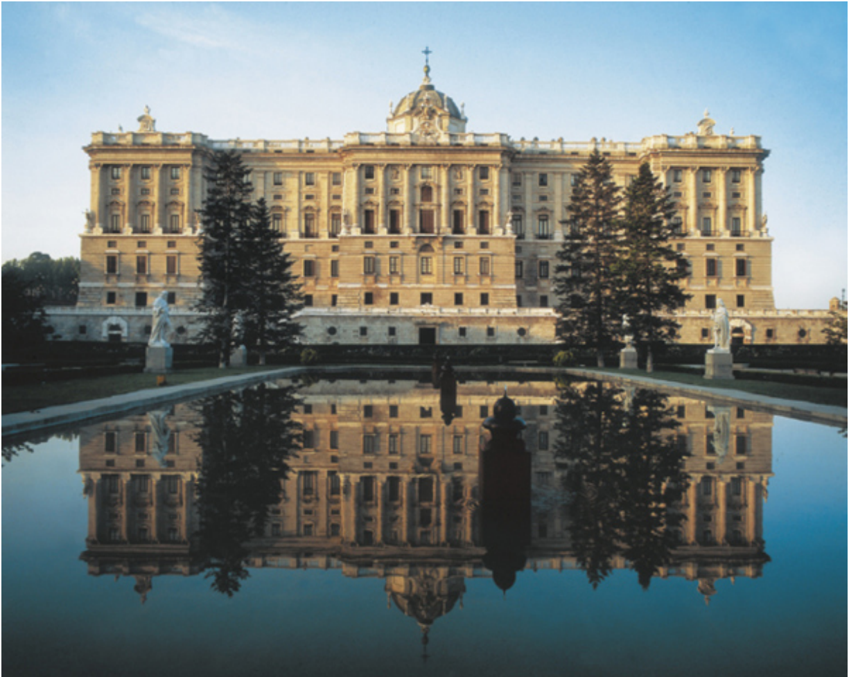
Vista del Palacio Real, Madrid, 1738-1764
