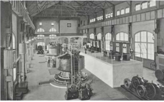
Generadores Westinghouse de 5000 HP en la planta de energía Edward Dean Adams en las cataratas del Niágara.
