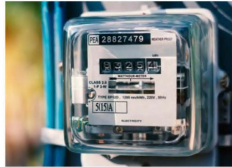
Moderno contador de vatios-hora de electricidad para uso en electrodomésticos.
